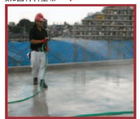
三次散水 (残剤洗浄)
