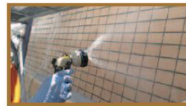
洗浄及び散水
